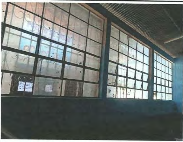
Foto 2: Sustitución de ventanas en mal estado
