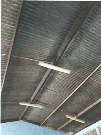
Foto1: Mejoramiento de lámina a lámina troquelada calibre 26.
