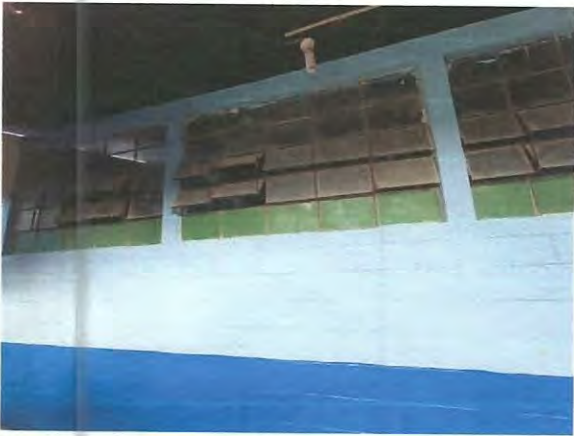
Foto 3: Mejoramiento y sustitución de ventanas
